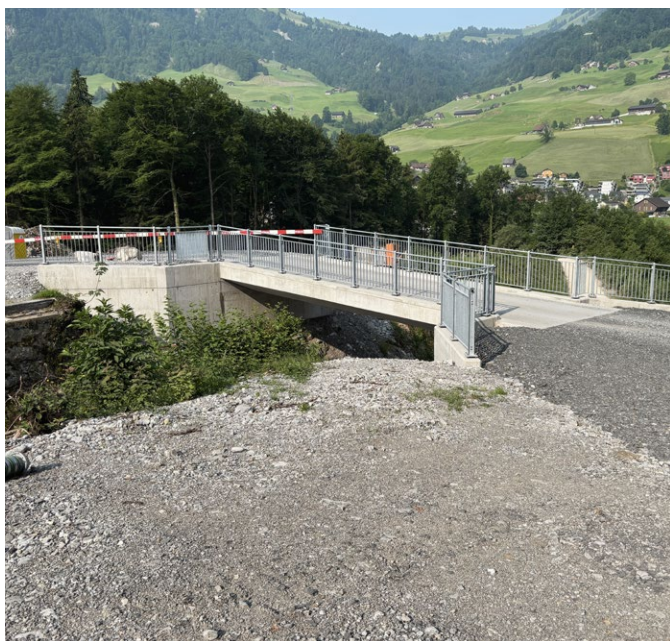
Neue Brücke Buoholz: 5 Meter breit und 14 Meter lang
