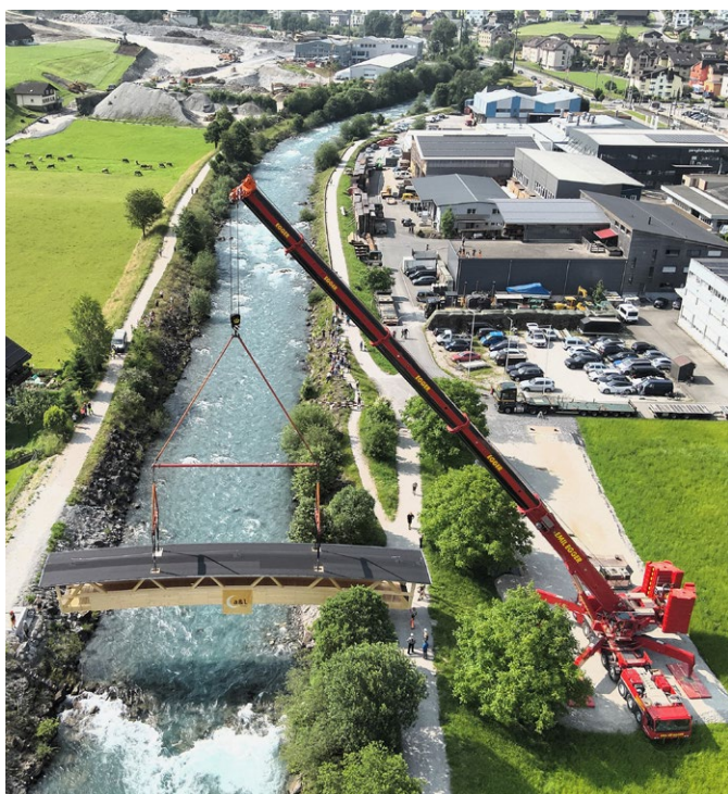
Bürersteg beim Einsetzen
