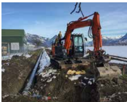
Leitungsbau in Richtung Ennetbürgen
