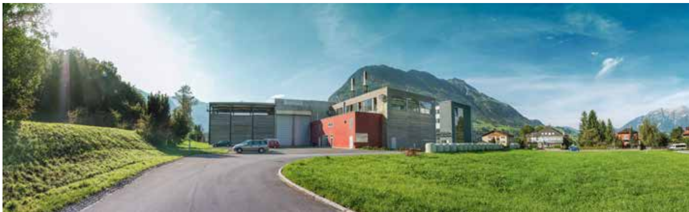
Das im Jahr 2007 erstellte Betriebsgebäude an der Aawasserstrasse in Oberdorf
