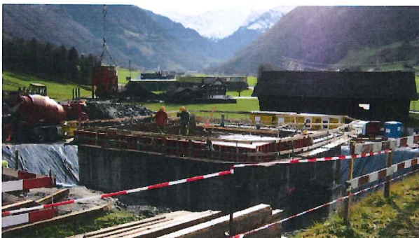
Baustelle Wasserkraftwerk Buoholzbach
