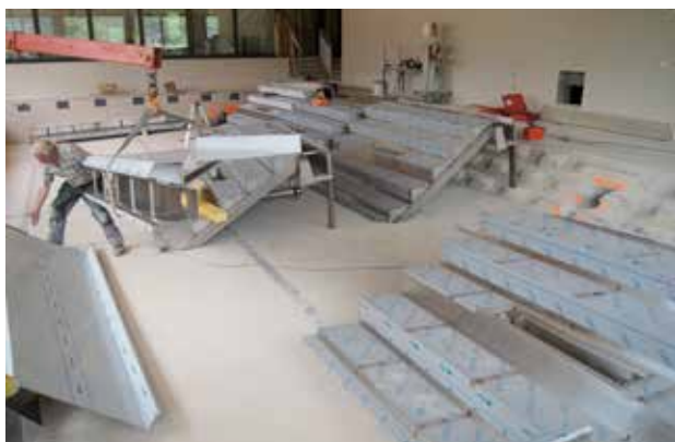
Anlieferung der Treppe
