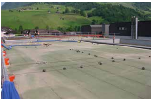
Vorbereitung für Photovoltaikanlage
