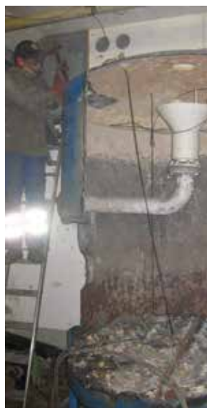
Demontieren des Wasserfilters
