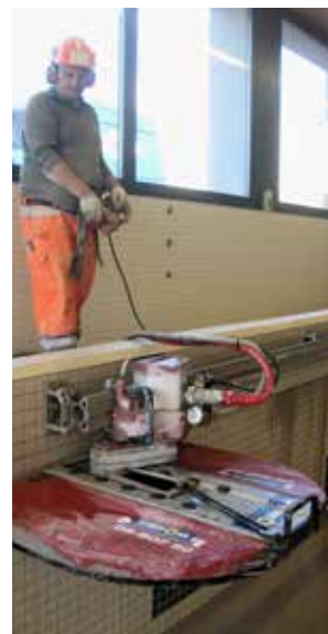
Fräsarbeiten am Beckenrand
