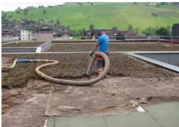
Vorbereitung für Photovoltaikanlage
