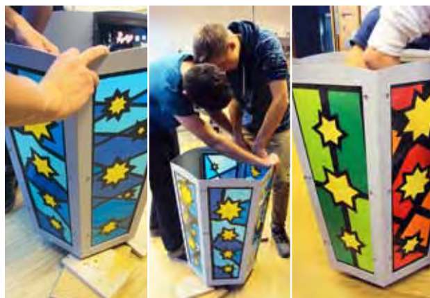
10 Montage der «Laternenfenster»
