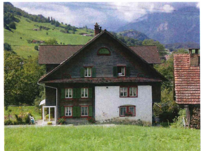
Bild oben: Ansicht von Südwesten Bild unten: Ansicht von Osten
