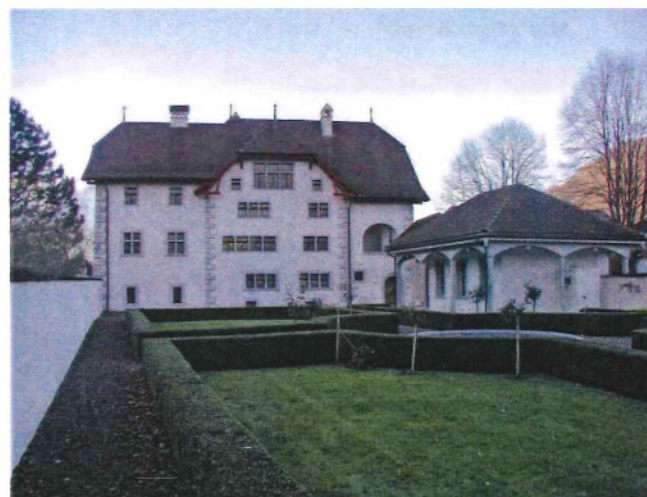
Bild oben: Ansicht von Nordwesten Bild unten: Ansicht von Südosten
