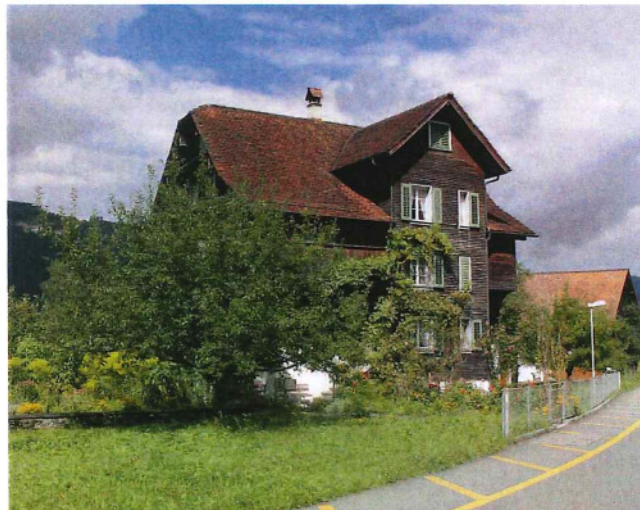
Bild oben: Ansicht von Osten Bild unten: Ansicht von Südwesten
