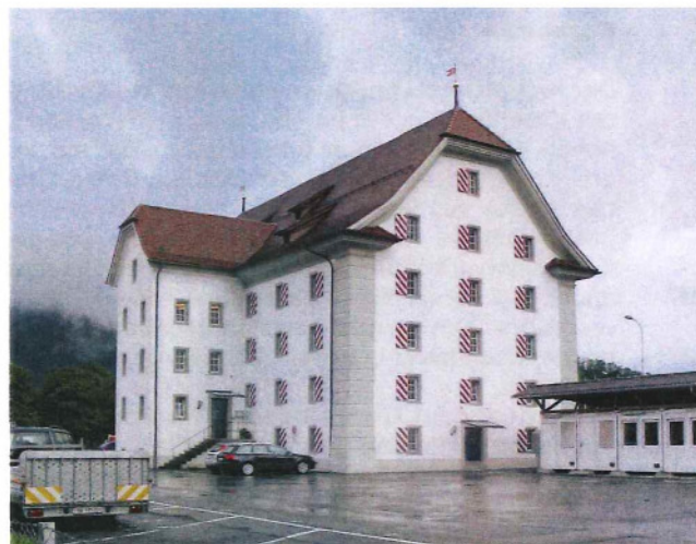
Bild oben: Ansicht von Nordosten Bild unten: Ansicht von Südwesten
