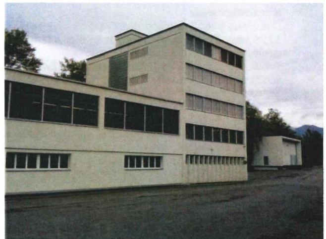
Bild oben: Ansicht von Nordosten Bild unten: Ansicht von Süden
