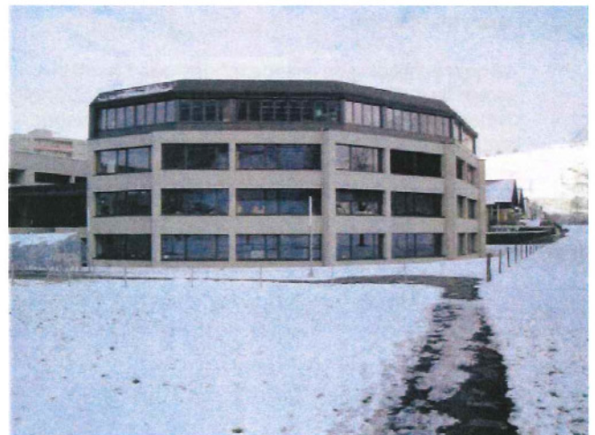
Bild oben: Ansicht von Südosten Bild unten: Ansicht von Westen
