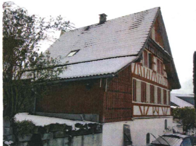
Bild oben: Ansicht von Nordwesten Bild unten: Ansicht von Südosten
