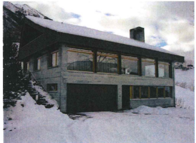
Bild oben: Ansicht von Nordwesten Bild unten: Ansicht von Nordosten
