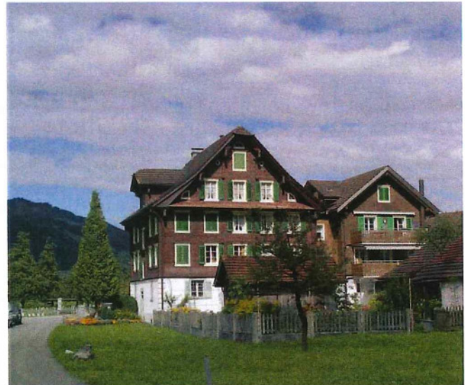
Bild oben: Ansicht von Nordwesten Bild unten: Ansicht von Südwesten
