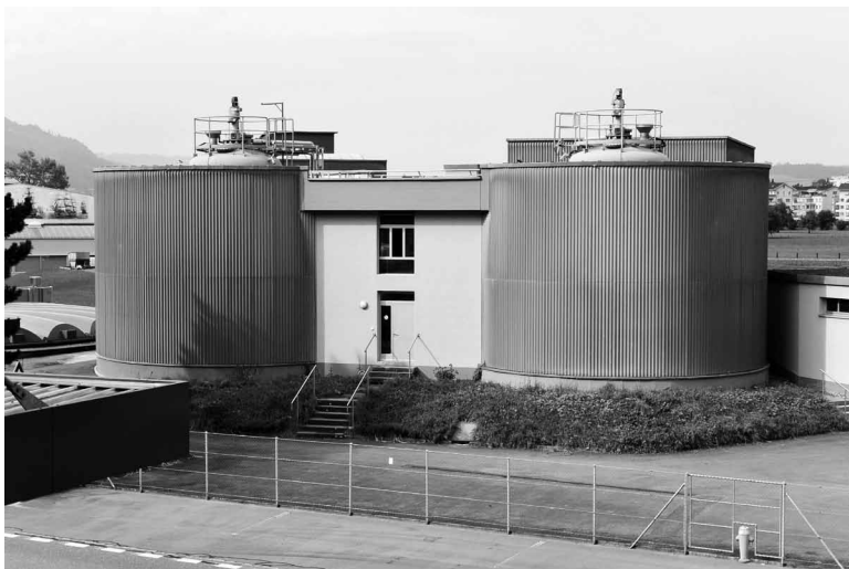
Faulräume 1 und 2 der ARA Rotzwinkel
