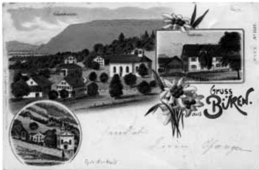
Gesamtansicht: alte Kirche Büren, Kohlrüti, Schulhaus, Schlössli, Turmatthaus und Stall. Kreis: Kirche mit Kaplanenhaus. Rechteck: Gasthaus Schlüssel, Tanzlaube und Schiessstand.
