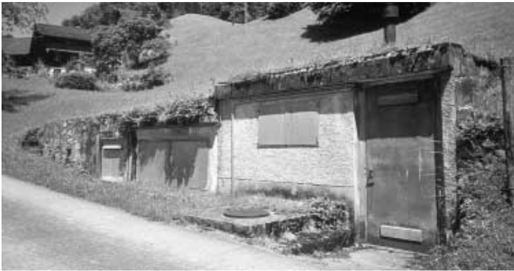
Brunnenstube Ursprung, Büren
